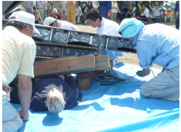
倒壊家屋の救助作業
