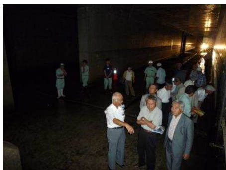
運動公園雨水調整池内部
