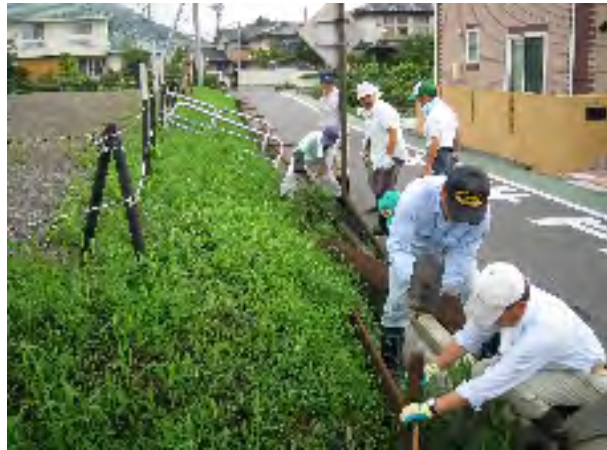
駐車場の法面に落石防止の柵を設置しました。
