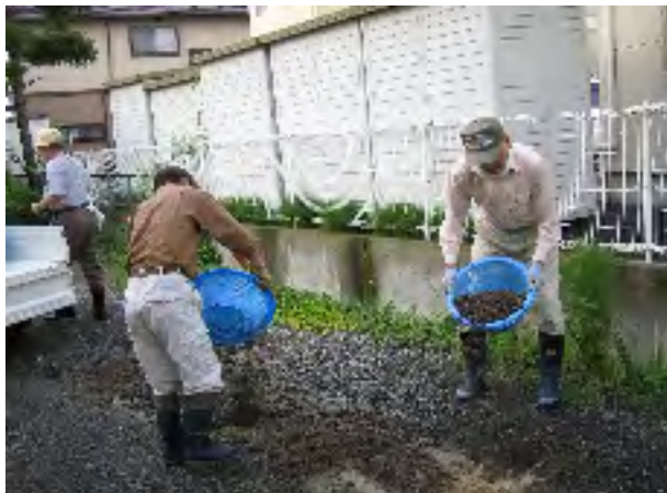
へこんだ部分に砕石を均しました。
