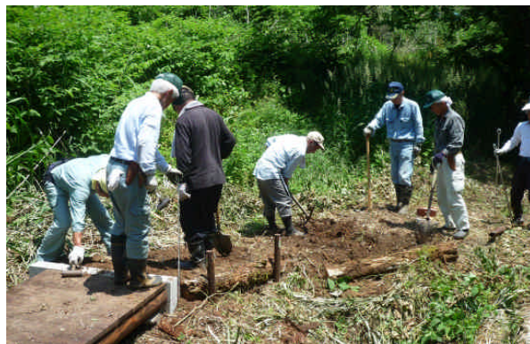
遊歩道の橋取付け作業
