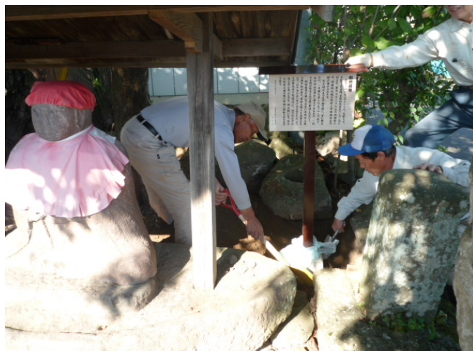
丁寧に水平をとって説明板の設置
