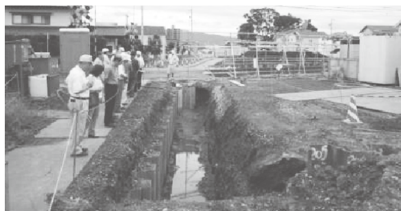
②長野電鉄アンダー工事箇所
