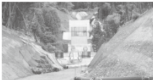
①橋梁工事箇所
