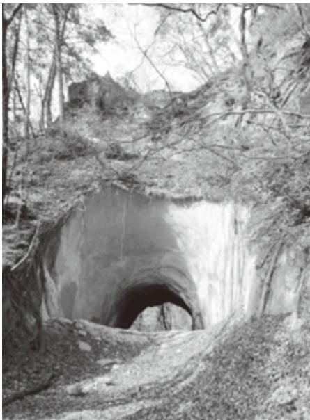
◀トンネル南側は崩落が激しく入口は元の高さの倍以上に広がっています。トンネルの左上に突起の残骸のようなものが見えますが。
